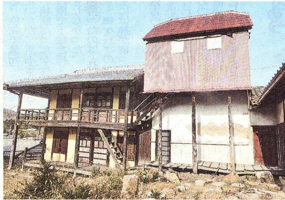
土蔵を改築し、観測室（建物の右側）や研究室を備えた私設天文台「山本天文台」（大津市桐生）
