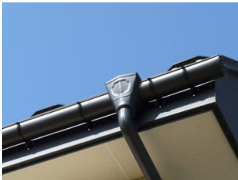
写真 4 屋根の雨樋と金具
